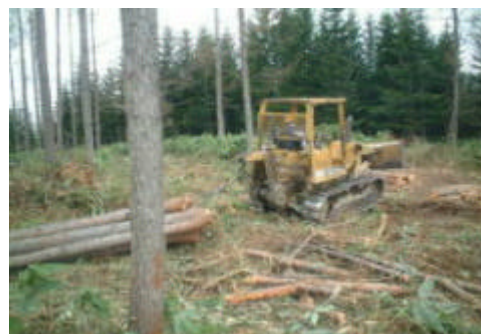
【間伐ブル集材作業】
