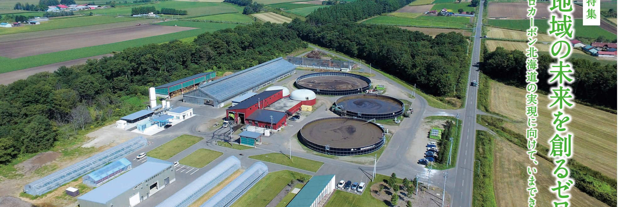
脱炭素先行地域の一つ、鹿追町のバイオガスプラント [取り組みは3ページをご覧ください]
