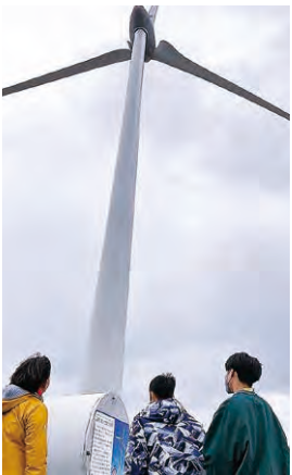
苫前町にある風力発電施設
