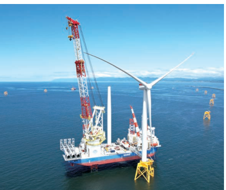
石狩湾新港での風車設置工事
