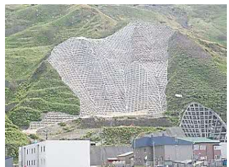
山腹崩壊後の 法枠工による復旧
