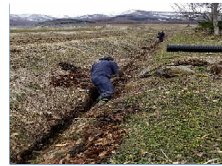
水路の泥上げ
