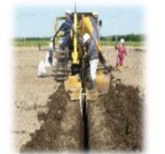
暗渠排水による農地の排水対策
