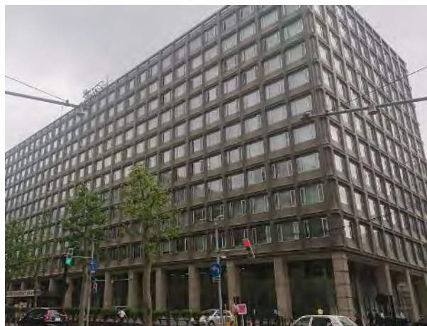
相談窓口外観 (北海道通信ビル)
