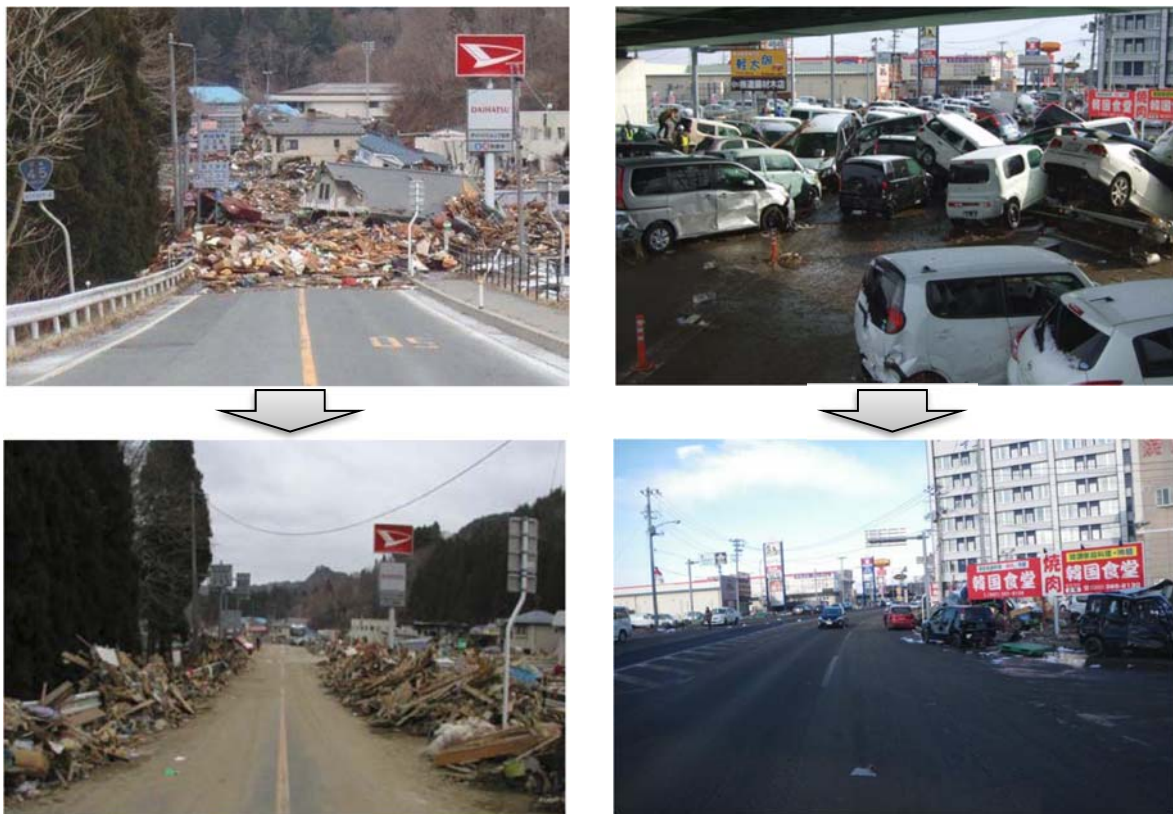
図 6 道路啓開（上：被災直後 下：道路啓開作業後） 10), 3)
