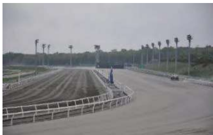
外走路改修 (H28)
