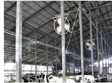
細霧冷房システム （ミスト機+送風機）
