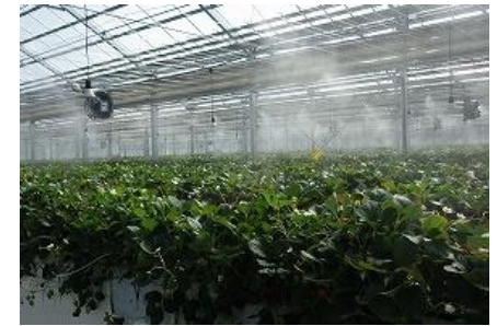
環境制御施設での細霧冷房 による昇温抑制事例
