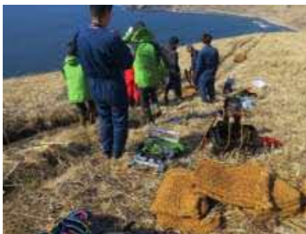
■歩道補修の様子
