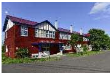
夏の雨煙別小学校の校舎
