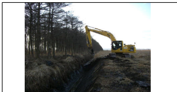
排水路の整備作業
