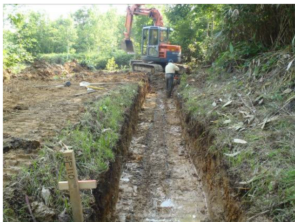
【用水路掘削作業】
