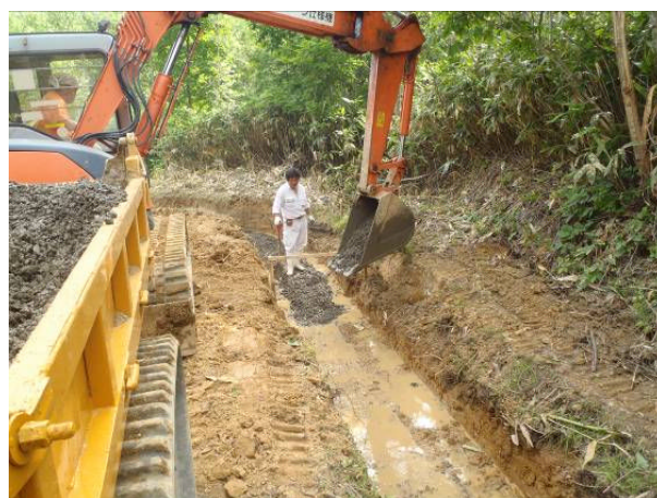
【用水路砂利敷き作業】
