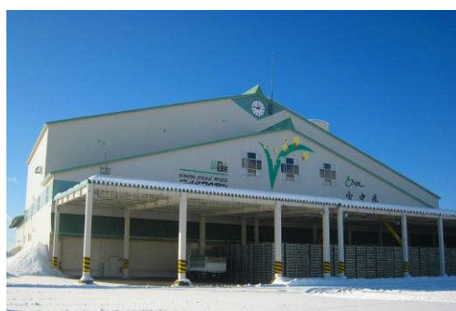
【共同利用施設 (乾燥調製施設)】
