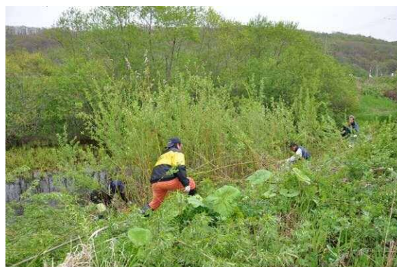
【排水路周辺の雑木の除伐】
