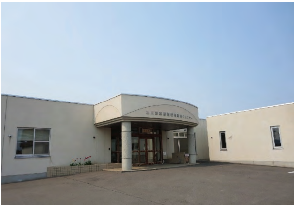
東鷹栖農村活性化センター「野土花」
