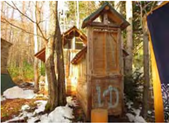
母屋から仕掛廊下で繋がる建物には五右衛門風呂あり
