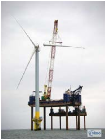
風車設置の様子
