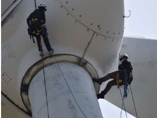
風車のメンテナンス作業（出典 北拓） WIND JOURNAL HP 参照
