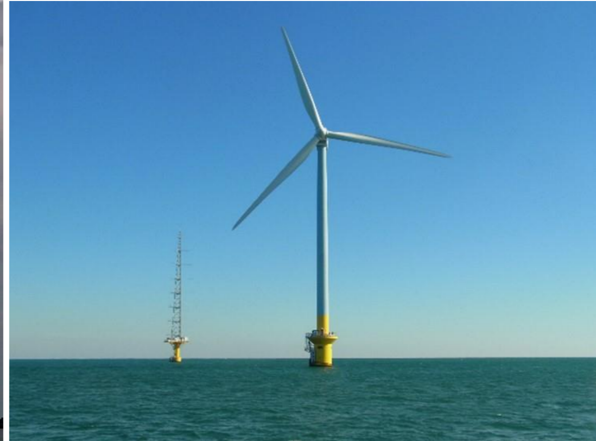
千葉県銚子沖の洋上風力発電
