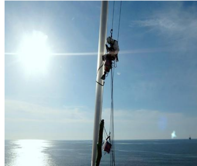
特殊高所技術によるブレード点検作業の様子
