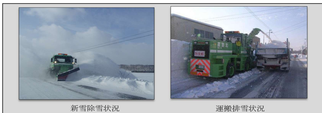
図 14 道道の除排雪状況
