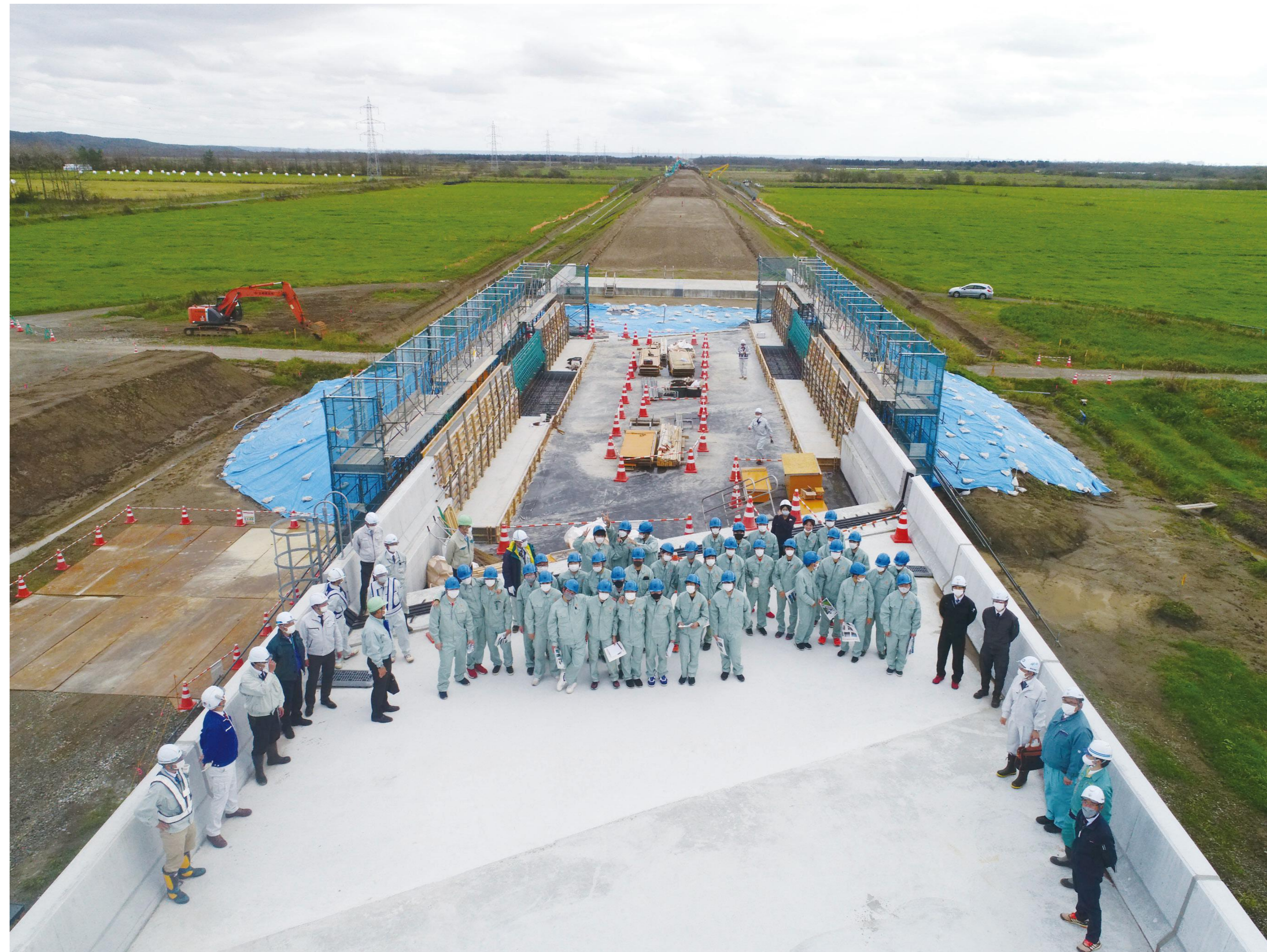
見学会実施状況(北海道横断自動車道ドローンによる撮影)
