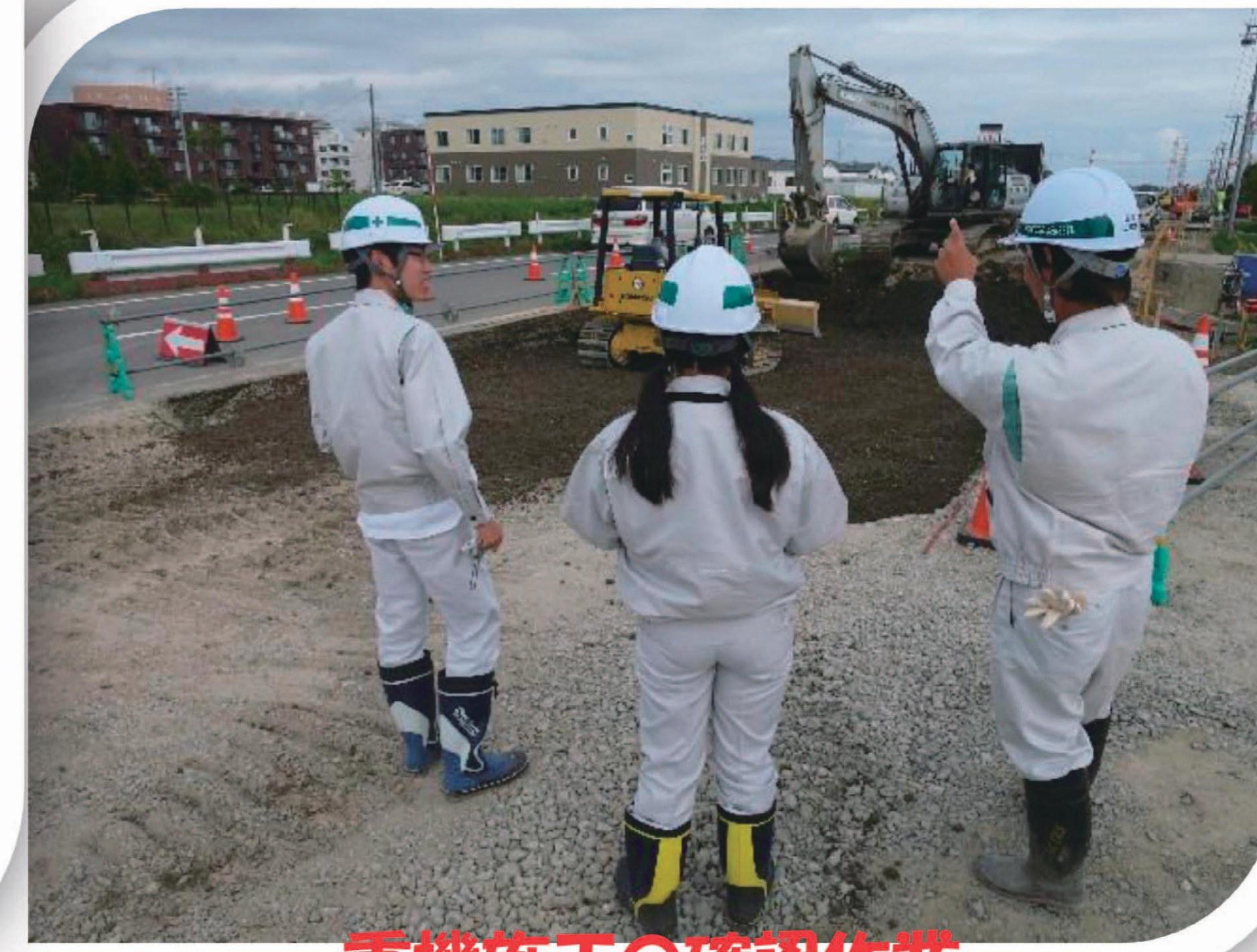
重機施工の確認作業
