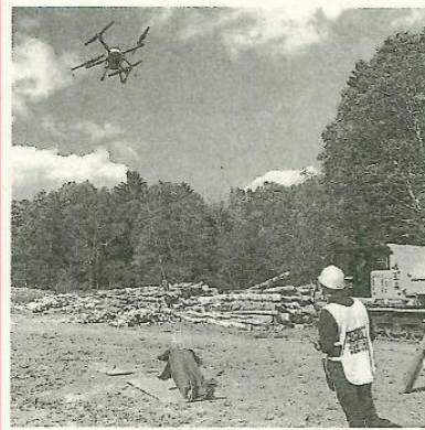
UAVで丸太や柵を現場まで運搬した
