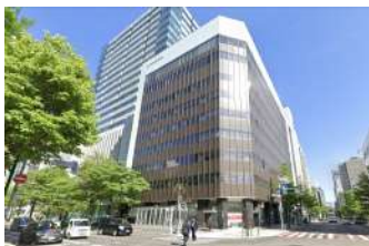
道新ビル（札幌市中央区） 9階建
