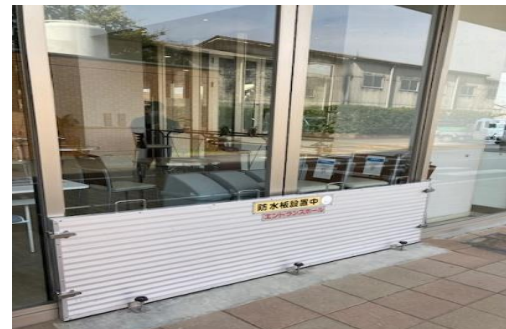
(止水板の設置)
