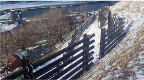
令和5年度時点施工状況
