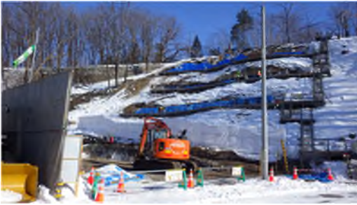
令和5年度時点施工状況
