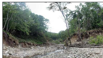
溪流荒廃状況 (上流)
