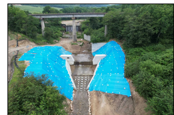
現在の施工状況
