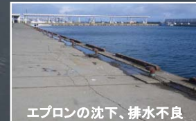
エプロンの沈下、排水不良
