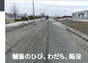
エプロンの沈下、排水不良
