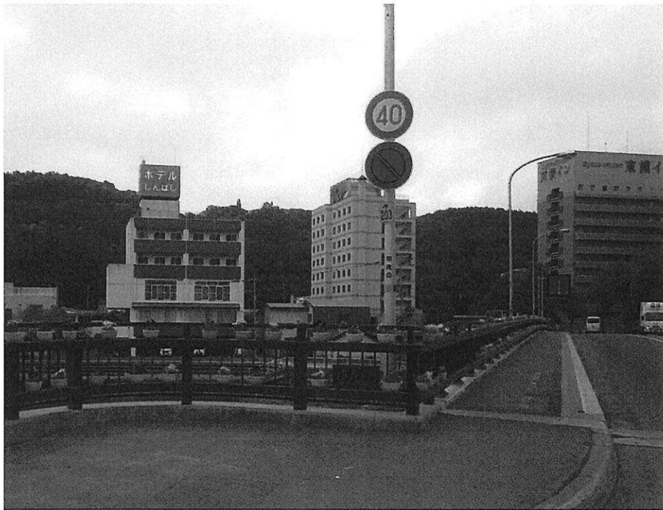
新橋の橋の欄干への花設置作業完了(令和4年 5月24日)
