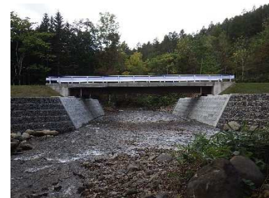
架け替えられた橋梁【上川北部】
