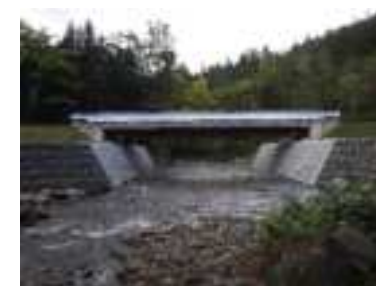
架け替えられた橋梁【上川北部】
