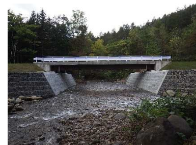
架け替えられた橋梁【上川北部】
