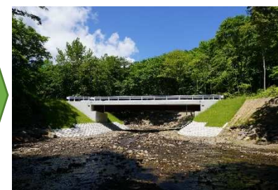
架け替えられた橋梁【渡島東部】
