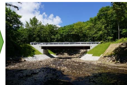
架け替えられた橋梁【渡島東部】
