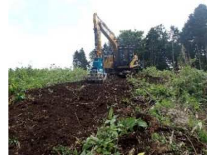
大型機械地拵【上川南部】
