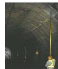
トンネル内のつらら落とし作業
