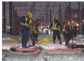
夜間のポイント除雪作業
