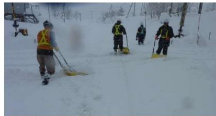
踏切の除雪作業
