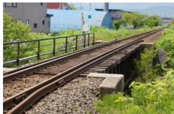
第2登川の橋りょう(1952年完成)
