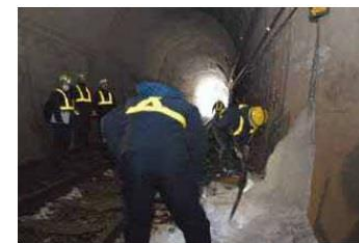
トンネル内の結氷除去作業
