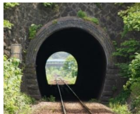
蘭島トンネル(1902年完成)
