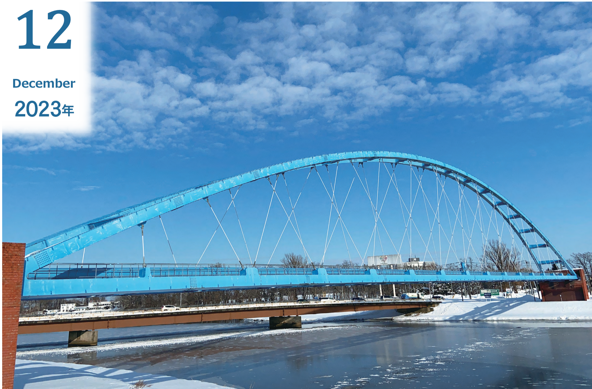
伏籠川水管橋(石狩湾新港地域)
