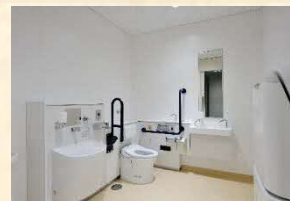
多目的トイレ
