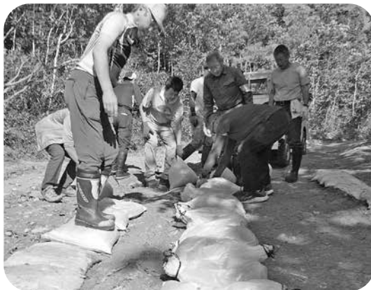
アクセス林道土のう補修
