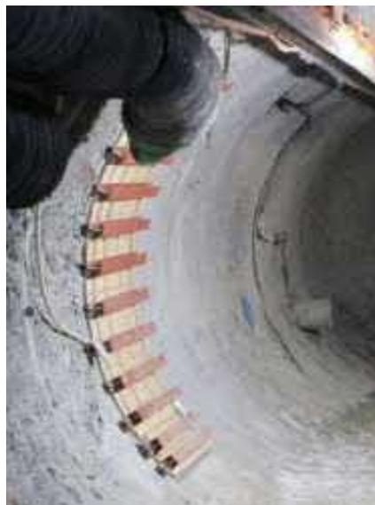
図 43 吹付け試験施工後の養生
