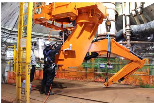
積込機の整備
