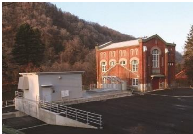
▲滝の上発電所 新（左）・旧（右）建屋
