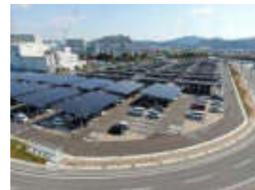
駐車場型メガソーラー 【岡山県瀬戸内市】
