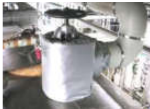
断熱ジャケットの装着
