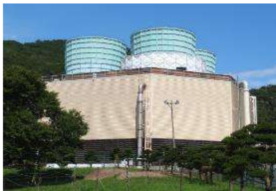
北海道電力(株) 森地熱発電所
