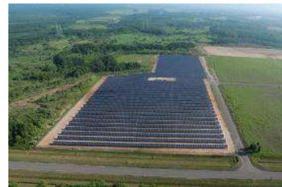
シャープ苫小牧第一太陽光発電所 (出典：シャープ)
