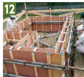
12 木造建築施工実習 型枠
