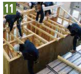
11 木造建築施工実習 2×4工法模擬家屋
