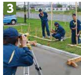
3 測量基本実習 水盛り遣り方
