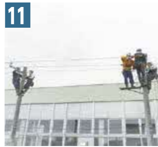
11 外線工事実習 電柱上の電気工事
