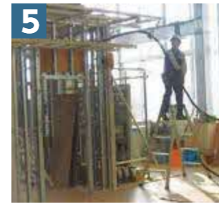
5 ケーブルラック実習 太い電線を配線する方法
