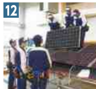
12 太陽光発電設備実習 太陽光発電の構成・組立て
