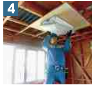
4 模擬家屋 電気工事実習 実際の電気・通信・TV工事
