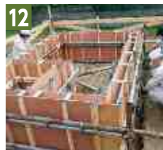
木造建築施工実習
