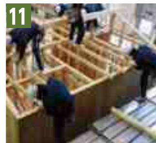
木造建築施工実習
